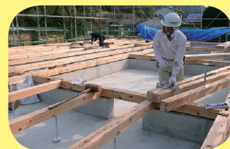
土台据え付け
